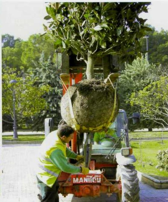
Preparación para la instalación de Arbofix®. Eliminación de la parte inferior del rete metálico del cepellón
